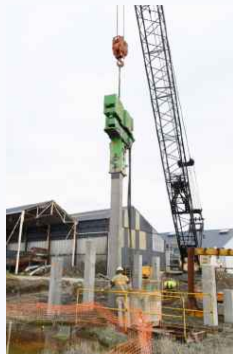
Suivi chantier promenade piétonne du port d'Étaples Crédit photo Jérôme POUILLE/ CD62
