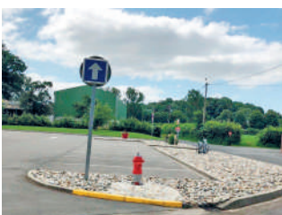
INSTALLATION D'UN POTEAU INCENDIE À POURET-SUR-CANCHE
