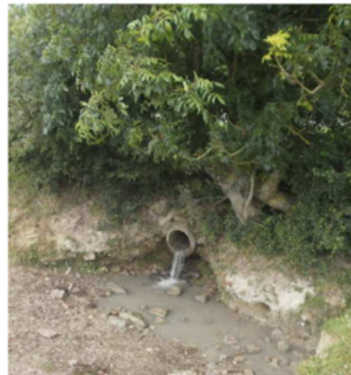
Photo 2 – ouvrage de franchissement de la route de la Blanche Jument – vue aval
