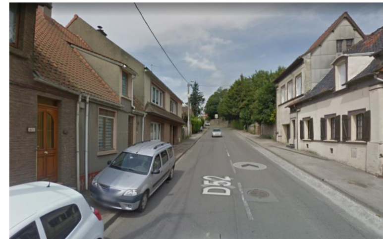
Vue sur la RD 52 de largeur 6,00m avec stationnement sur trottoirs étroits et empiètement sur la voie de circulation Linéaire concerné 210 m
