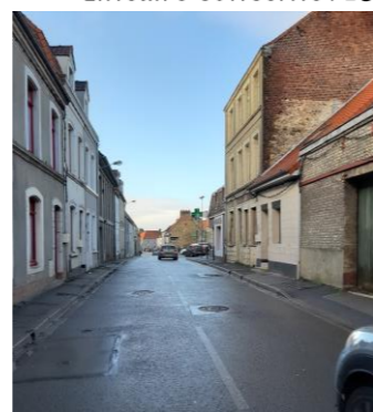
Vue sur la chaussée de largeur 5,30 m avec ses trottoirs étroits Linéaire concerné : 234 m
