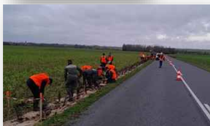
Chantier participatif – Chaussée Brunehaut
