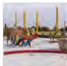
Oignies • Construction d'un nouveau programme immobilier de 24 logements
