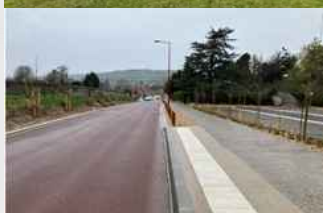
Chantier Maintenance en Milieu Urbain - (MMU)- commune de Baincthun
