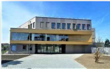
Calais, nouvelle entrée du collège Lucien Vadez
