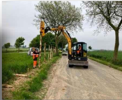
Bassin RD341 – printemps 2023 – pose de clôtures – CER de Coyecques
