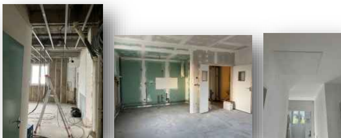
Désamiantage et rénovation complète du logement de fonction du futur gardien au collège Jean Rostand à Auchy-les-Hesdin
