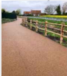
EV4 à Nouvelle-Eglise
