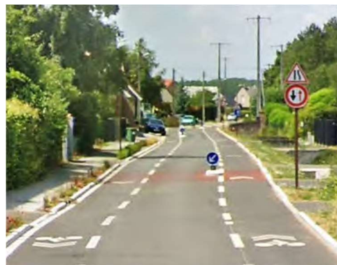
CVCB avec chicanes et bypass cyclables à Saint-venant (ADAV)
