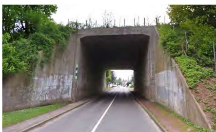
Franchissement inférieur de l'autoroute A 26 (EV5) par réduction de la voie centrale et élargissement unilatéral du cheminement actif.
