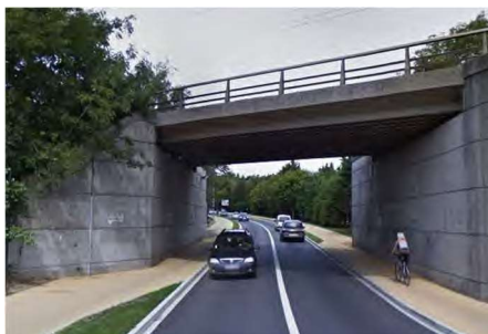
Franchissement inférieur de la voie ferrée à Etaples (EV4) par réduction de la voie centrale et élargissement bilatéral des cheminements actifs avec revêtement coloré.
