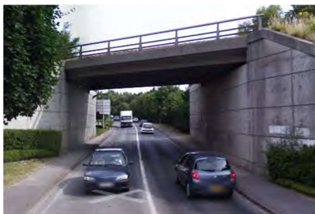
Franchissement inférieur de la voie ferrée à Etaples (EV4) par réduction de la voie centrale et élargissement bilatéral des cheminements actifs avec revêtement coloré.
