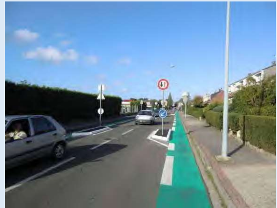
Exemple d'écluse avec by-pass (ADAV)
