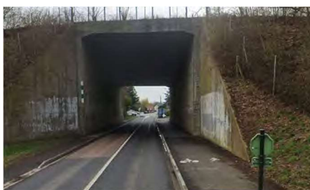
Franchissement inférieur de l'autoroute A 26 (EV5) par réduction de la voie centrale et élargissement unilatéral du cheminement actif.
