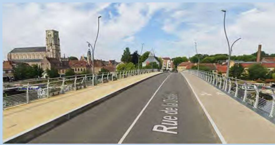
Élargissement de l'espace dédié aux modes actifs par encorbellement (Wambrechies)
