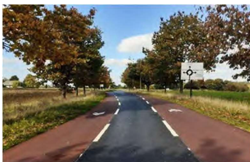
CVCB efficace avec voie centrale volontairement resserrée à son minimum au bénéfice de larges bandes de rive (ADAV).
