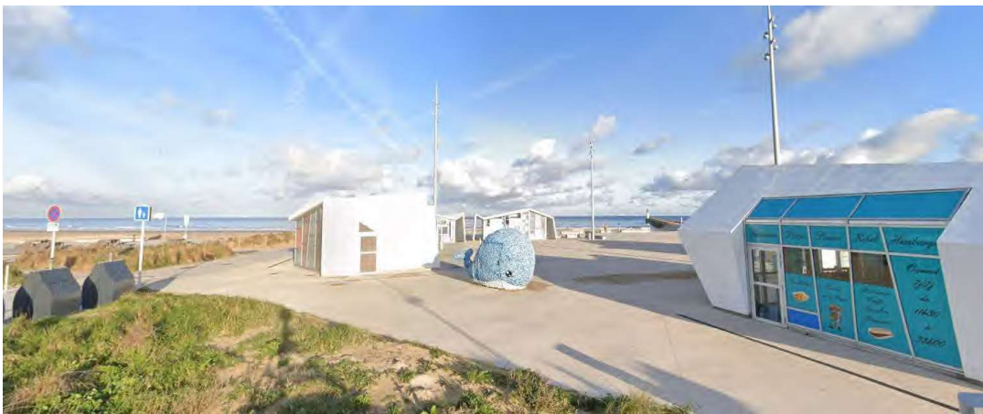
Aire piétonne à Calais traversée par l'EV4
