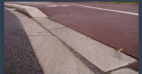
Jonction avec des bordures béton larges
