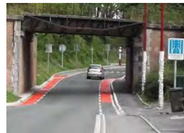
CVCB ponctuelle sur point dur. La voie centrale reste ici, malgré tout, trop large (ADAV).
