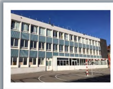
Juillet - Réhabilitation du collège Jean Jaurès - Calais (1ère partie) - Chantier sur 2 ans Montant des travaux départementaux: 2 M€
