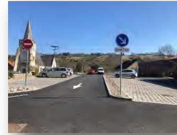
Février - Inauguration de l'aire de stationnement multifonctionnelle - Elnes Montant de la subvention: 29 803 €
