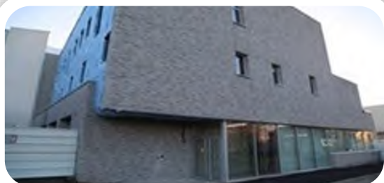
Reconstruction du Centre d'Incendie et de Secours
