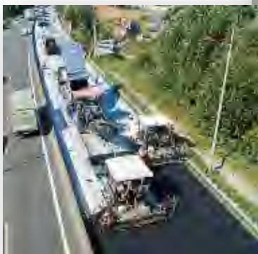
Requalification de la RD 301 section Hersin-Coupigny/Barlin
