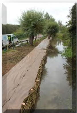
Renforcement des berges Calaisis
