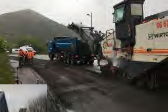
Renouvellement de chaussée à Méricourt / D262
