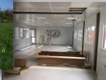
Installation d'un module / collège Monnet Aubigny
