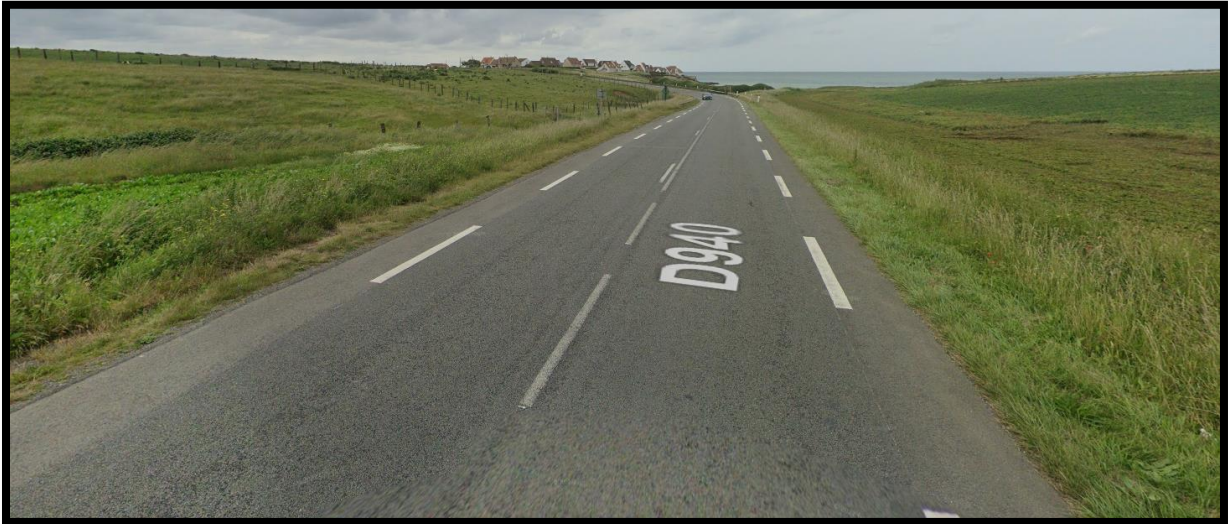
Profil de la RD940 - 5m50 de chaussée et 1m de bandes de rives
