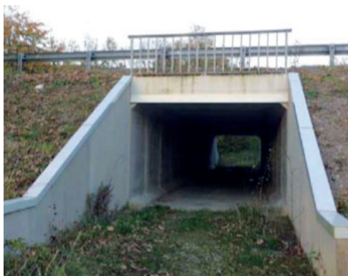
Ouvrage de traversée hydraulique existant sous la RN42. ©Egis.
